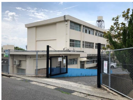
③ 給食室側車両通用門(施工前)
